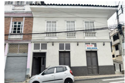
Fig. 65. Vivienda Cabrera-Calle. Imagen: propia
