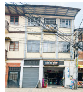
Fig. 57. Vivienda Terán. Imagen: propia
