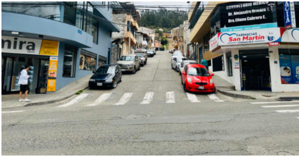
Fig. 93. Calle 3 de noviembre, hacia Av. Calderón. Imagen: propia
