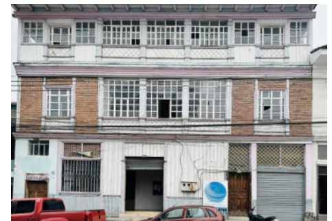
Fig. 66. Vivienda Mata. Imagen: propia
