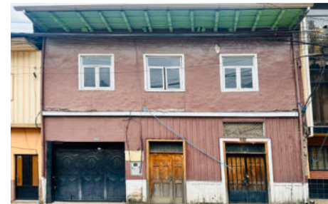
Fig. 55. Vivienda Ortiz. Imagen: propia
