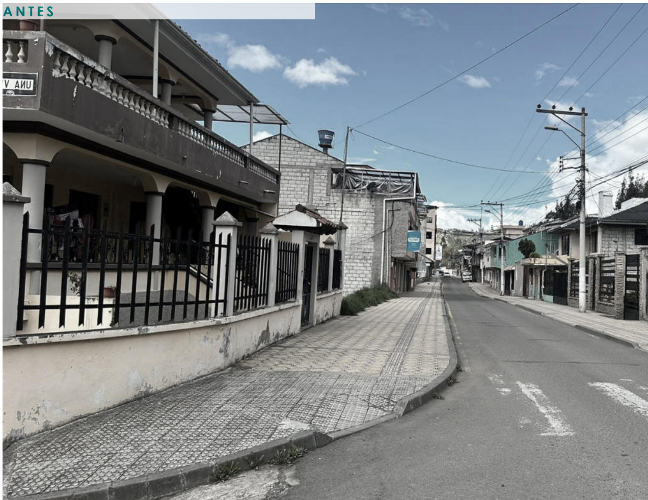
Fig. 180. Estado actual de la calle Sucre en el tramo 02. Imagen: propia
