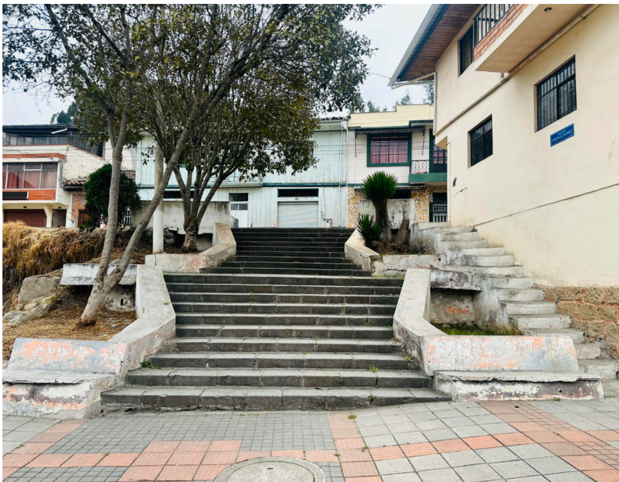
Fig. 114. Escalinata Federico González. Imagen: propia
