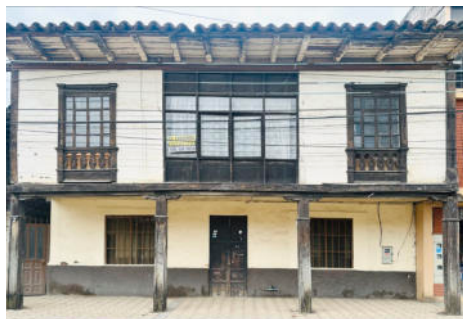
Fig. 51. Vivienda Salamea. Imagen: propia
