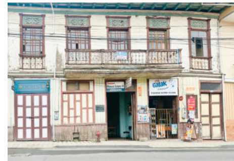
Fig. 56. Vivienda Barreto-Ávila. Imagen: propia
