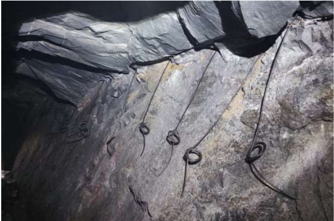
Figura 15. Preparación para voladura.
