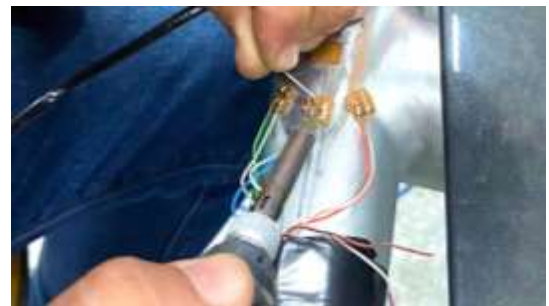
Fig 10. Soldado de cables a terminales de las galgas
