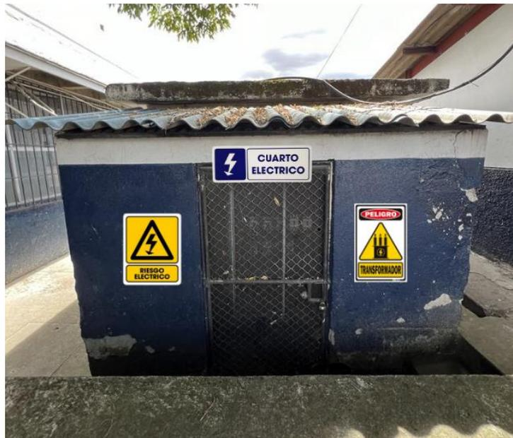
Figura 3.13: Propuesta señalización para transformadores
