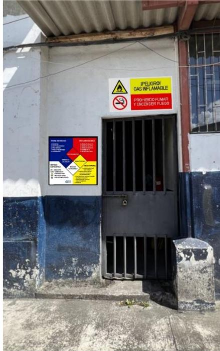
Figura 3.12: Propuesta de señalización cuarto de gases
