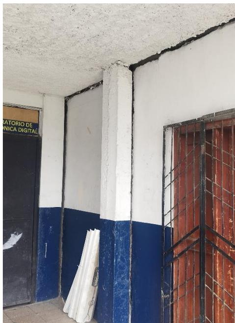
**Figura 2.3:** Columna con deterioro en la edificación del Bloque 5
