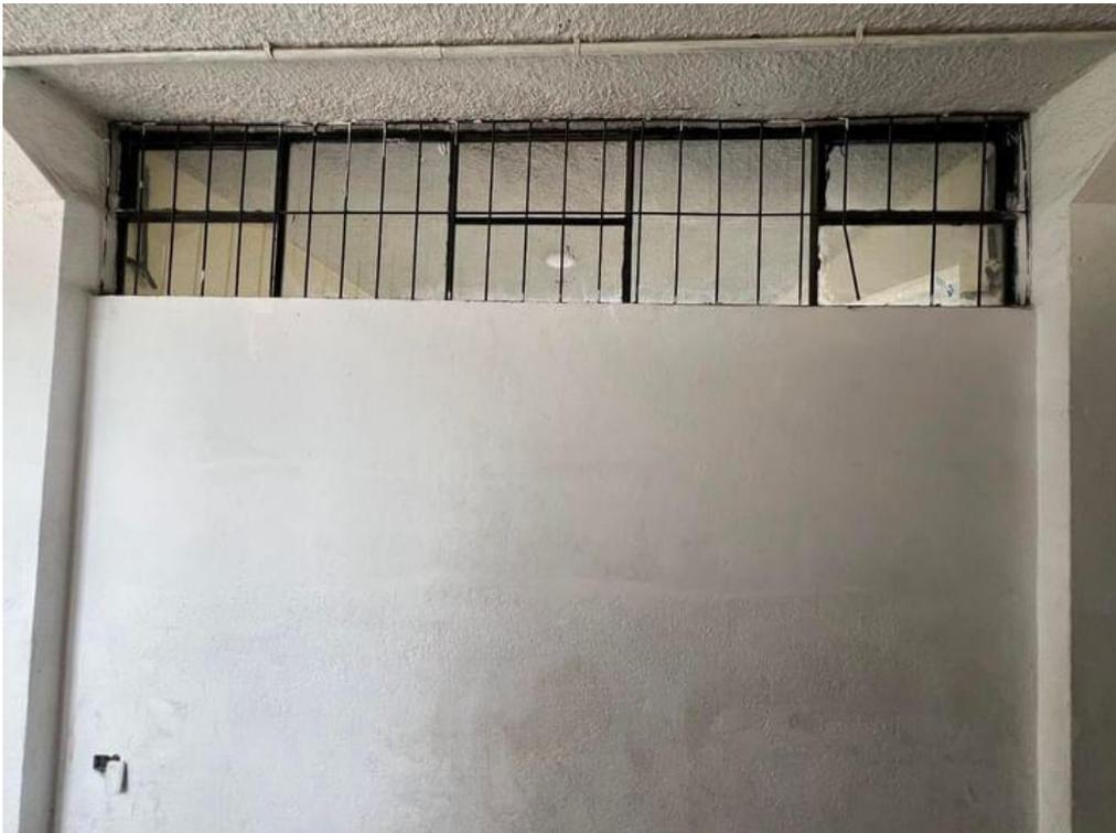
Se ha identificado la presencia de un efecto de columna corta.
