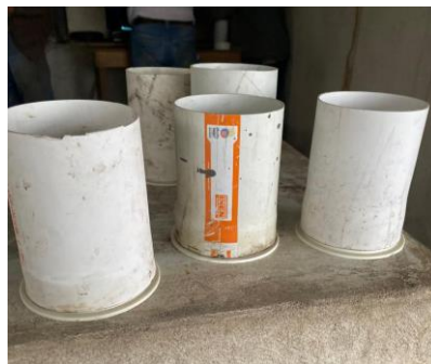
Figura 4. Elaboración de moldes para verter la mezcla
