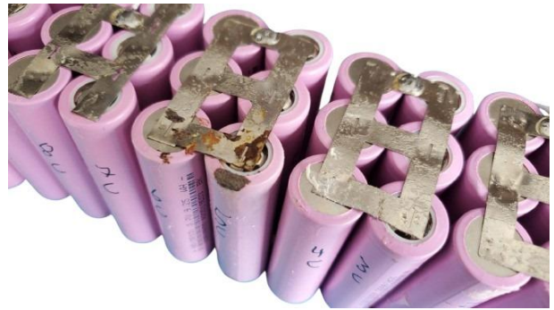
Figura 13. Bloque de celdas (Daño por corrosión).
