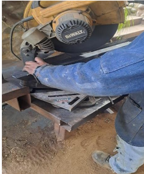
Figura 33: Corte y preparación de tubos
