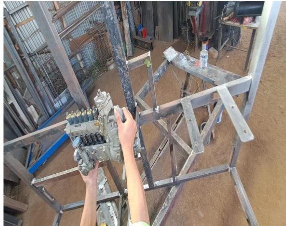
Figura 35: Montaje y Fijación de soportes para la bomba
