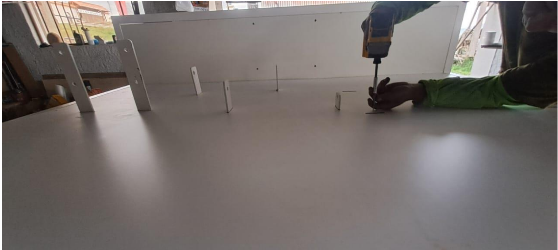
Figura 39: Colocación de la plancha Melamina
