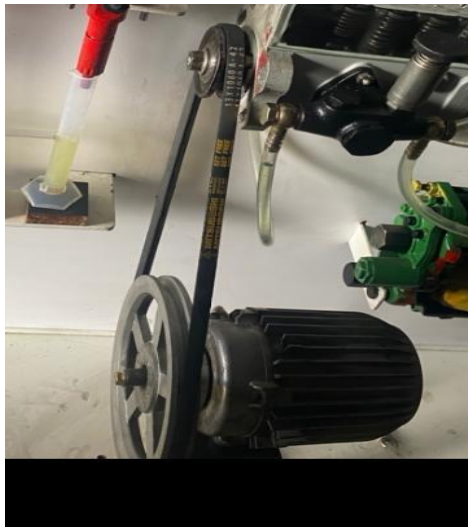
Figura 52: Asentamiento del motor eléctrico
