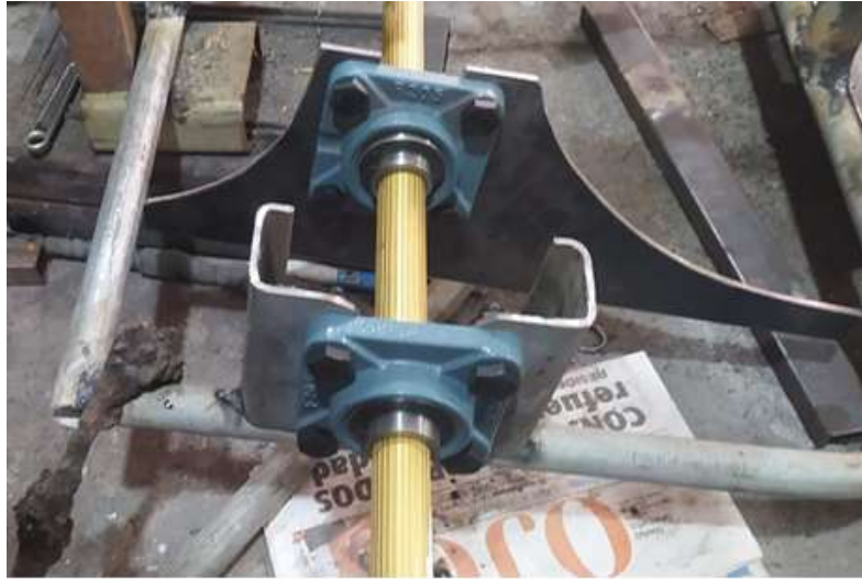
Figura 1.18. Soldadura de las bases en la estructura
