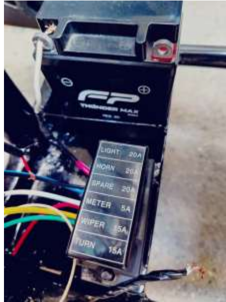
Figura 1.49. Montaje de fusiblera
