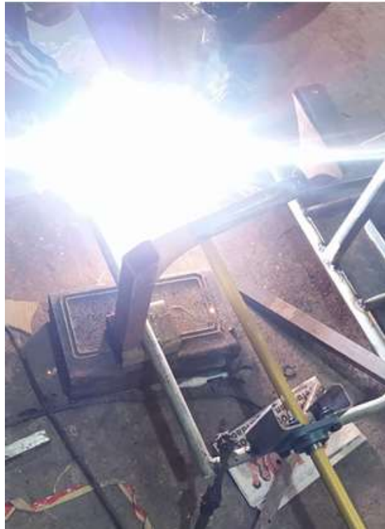
Figura 1.14. Soldadura de las bases para las chumaceras
