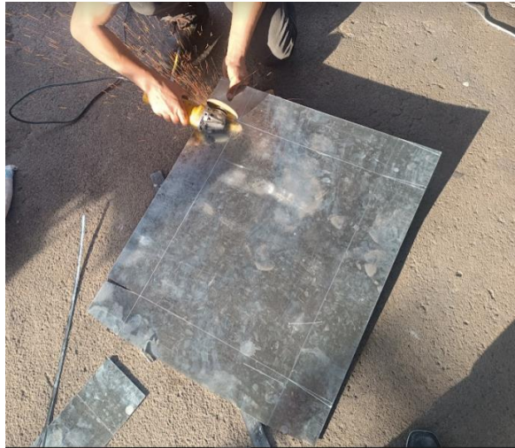
Figura 20 Realización de la caja de lata galvanizada
