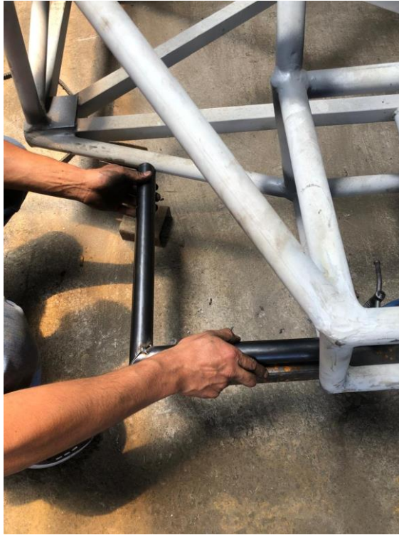
Figura 20. Colocación de soporte
