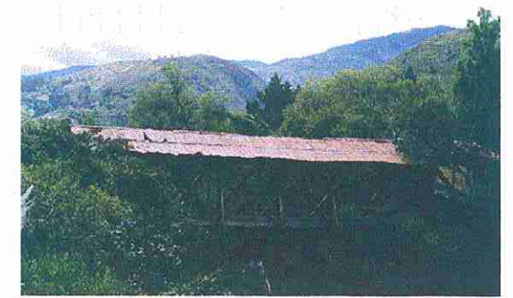
Puente de Chacapamba
