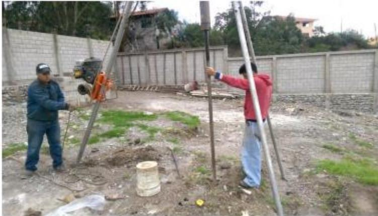
Figura 1.6 Equipo de perforación por percusión, de funcionamiento mecánico
