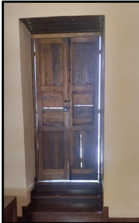
Teatrina Casa de la Provincia (Enfoque puerta)
