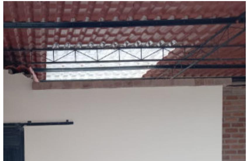
Tragaluces de cubierta plástica transparente, ubicadas sobre las áreas de escaleras y baño.
