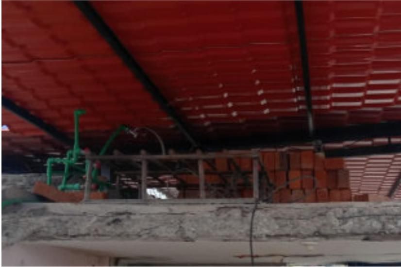
Tuberías de termofusión para agua caliente y fría se encuentran instaladas por encima del cielo raso y por debajo de las cubiertas plásticas.
