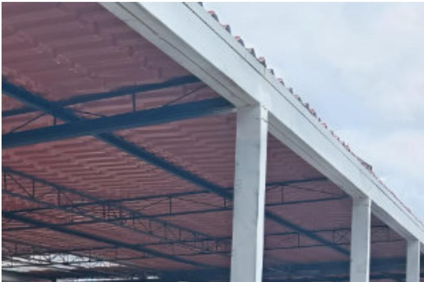
Estructura metálica con pilares rectangulares vigas G soldadas y vigas reticuladas de refuerzo.
