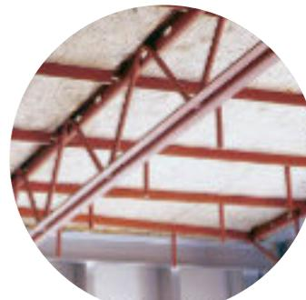
Vigas de acero reticuladas, Tectónica.
