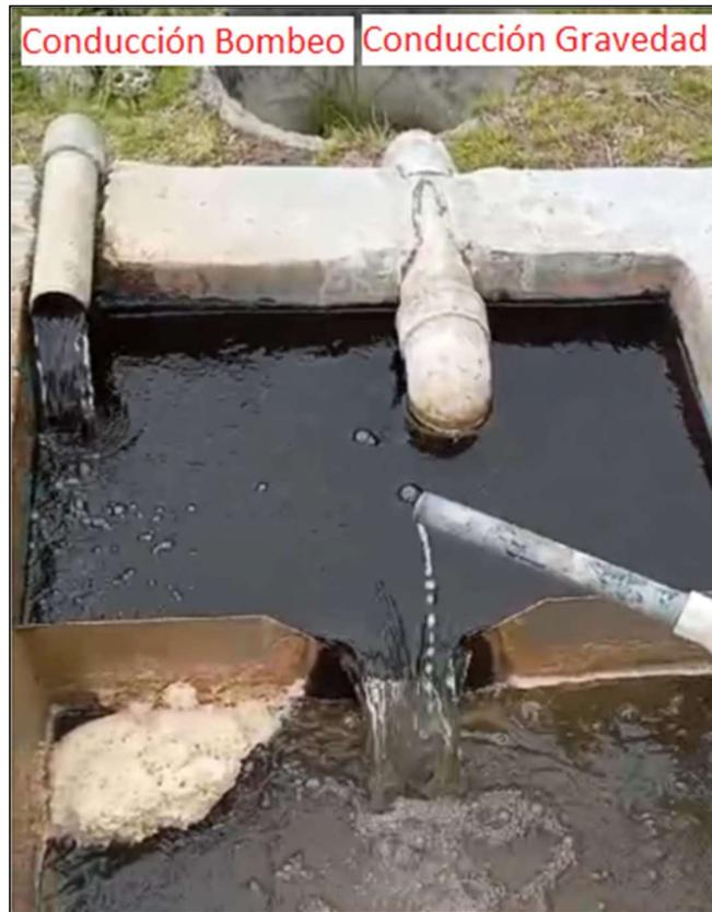
**Figura 7. Cajón de llegada de agua cruda a la Planta de Agua Potable Bella Unión – Fuente:
