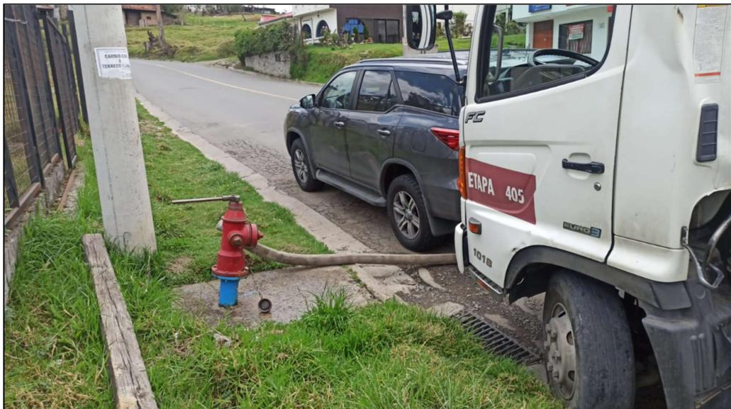
**Figura 48. Hidrante del Paraíso para carga de tanqueros - Fuente: Autor**
