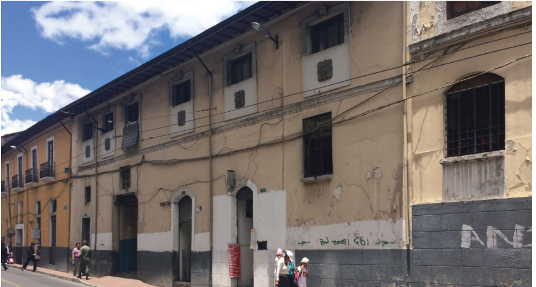
Fig. 10. Conventillos en malas condiciones o deteriorados en la Ciudad de Quito. Fuente: https://www.primicias.ec/noticias/quito/bienes-imnuebles-patrimonio-danos-casas/
