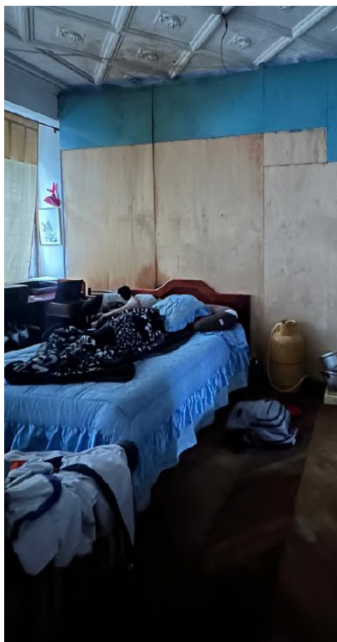
Fig. 13. Casa Brito. Fuente: Ávila (2023)
