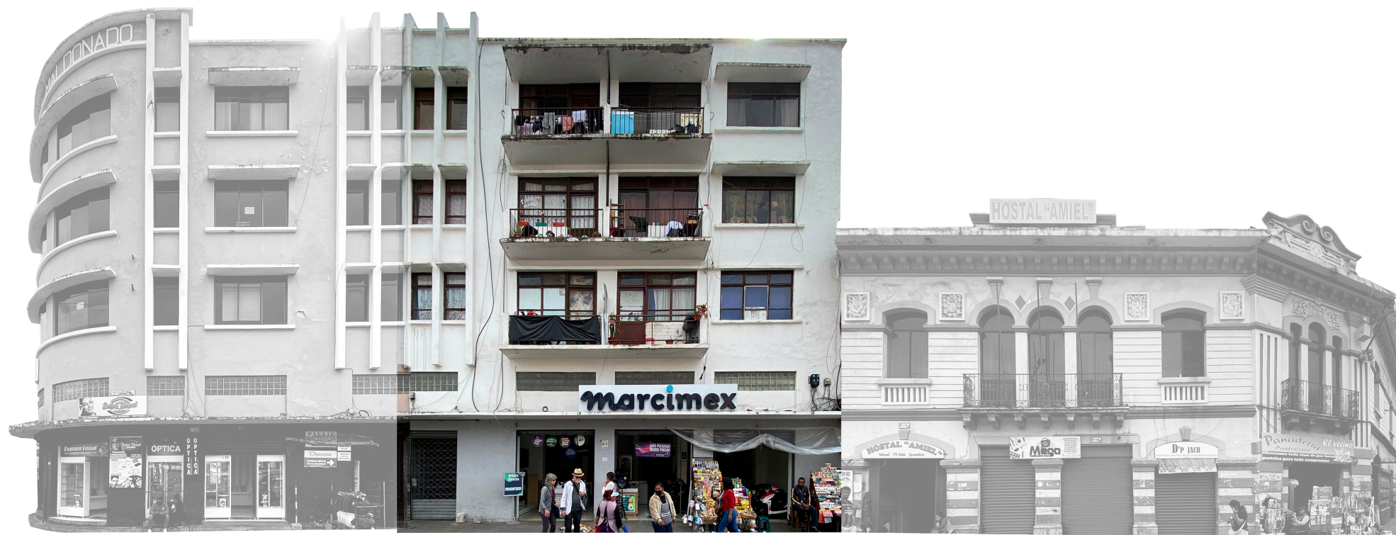
Fig. 38: Fachada desde la calle Mariano Cueva. Elaboración propia.
