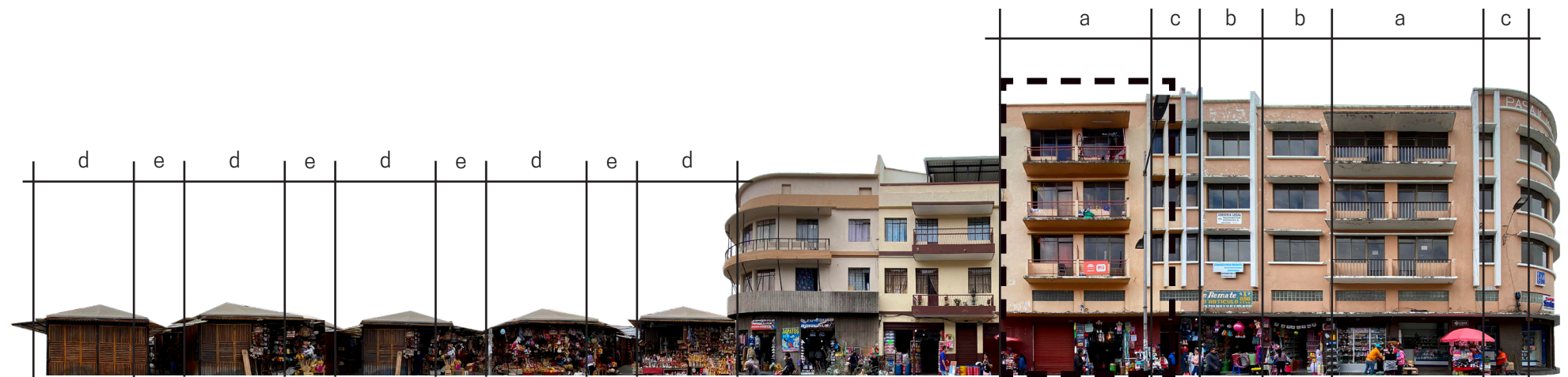
Fig. 45: Tramo calle Gaspar Sangurima. Fuente: Elaboración propia
