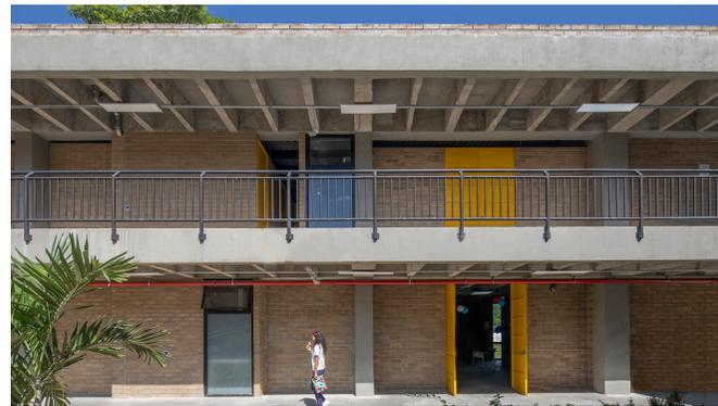
Fig. 21. Contraste de la mampostería de ladrillo frente al concreto.
