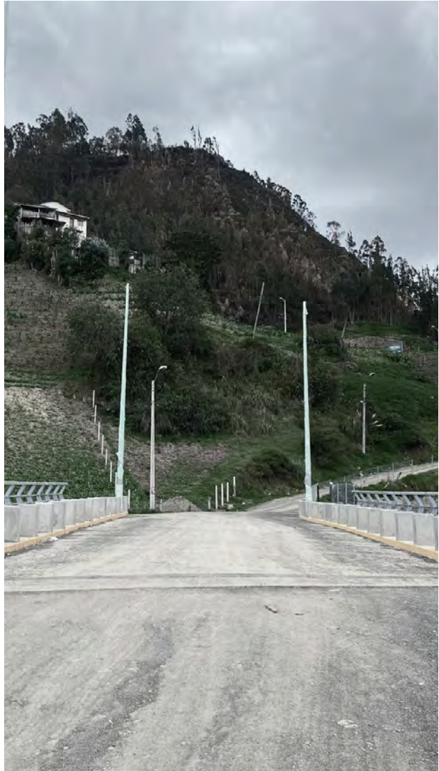
Imagen 11. Puente vehicular en el sector de la feria de ganado de Biblián Fuente: Propia
