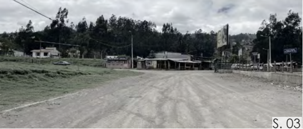
S. 03 Imagen 14. Vía de descarga del ganado Fuente: Propia
