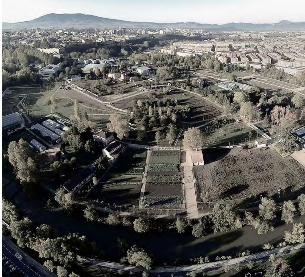
Imagen 23. Vista aérea del parque Aranzadi Fuente: Peralta Ayesa Arquitectos
