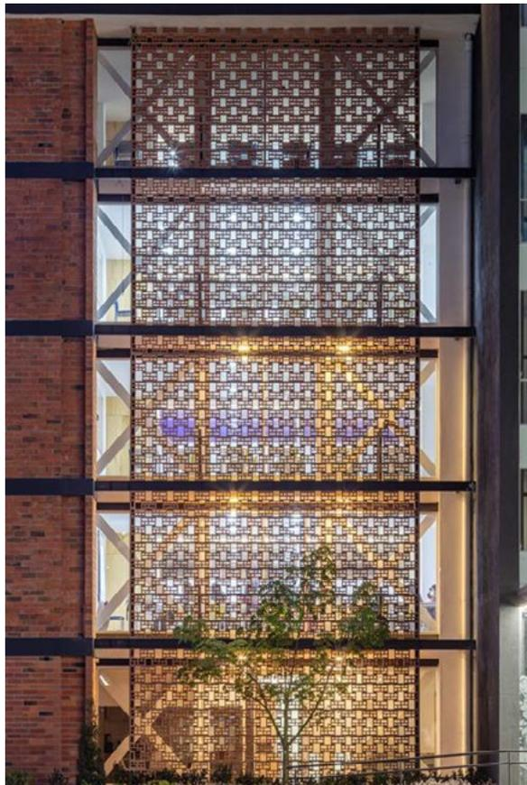
Fig 36. Celosía de ladrillo para control solar
