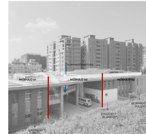
fig. 17. Esquema análisis formal estación DA-YO. Fuente: Elaboración propia
