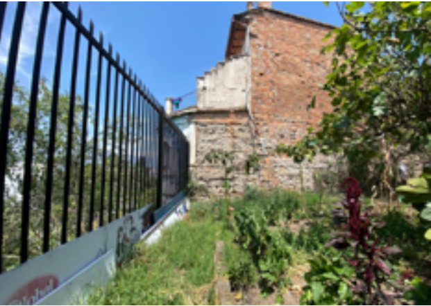
Figura 62: Vista de la vegetación y la cerca de acero Fuente: Autoria propia (2025)
