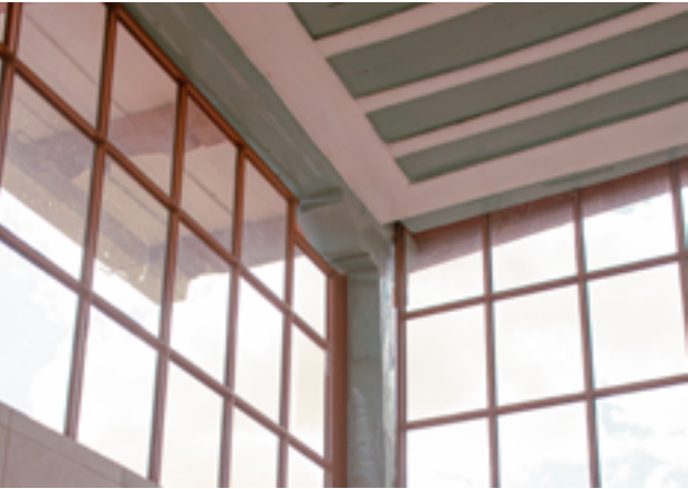
Figura 59: Vista de la columna original de madera Fuente: Autoria propia (2025)
