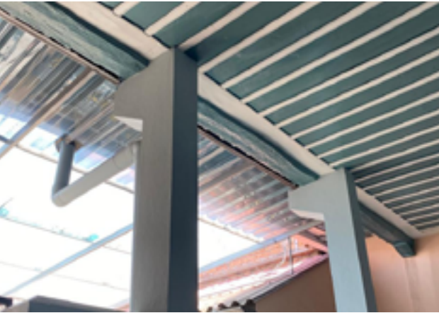
Figura 58: Vista de las columnas de hormigón Fuente: Autoria propia (2025)
