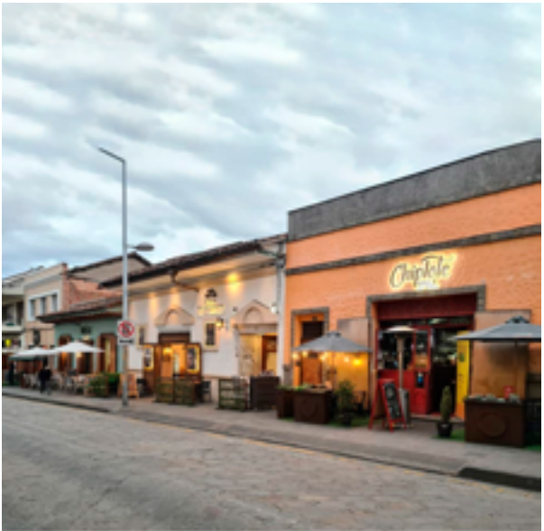
Figura 06: Apropiación de viviendas para uso comercial en la Calle Larga Fuente: Robert Lety (2022)
