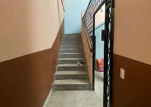
Figura 57: Vista hacia la escalera desde el pasillo de ingreso de la vivienda Fuente: Autoria propia (2025)
