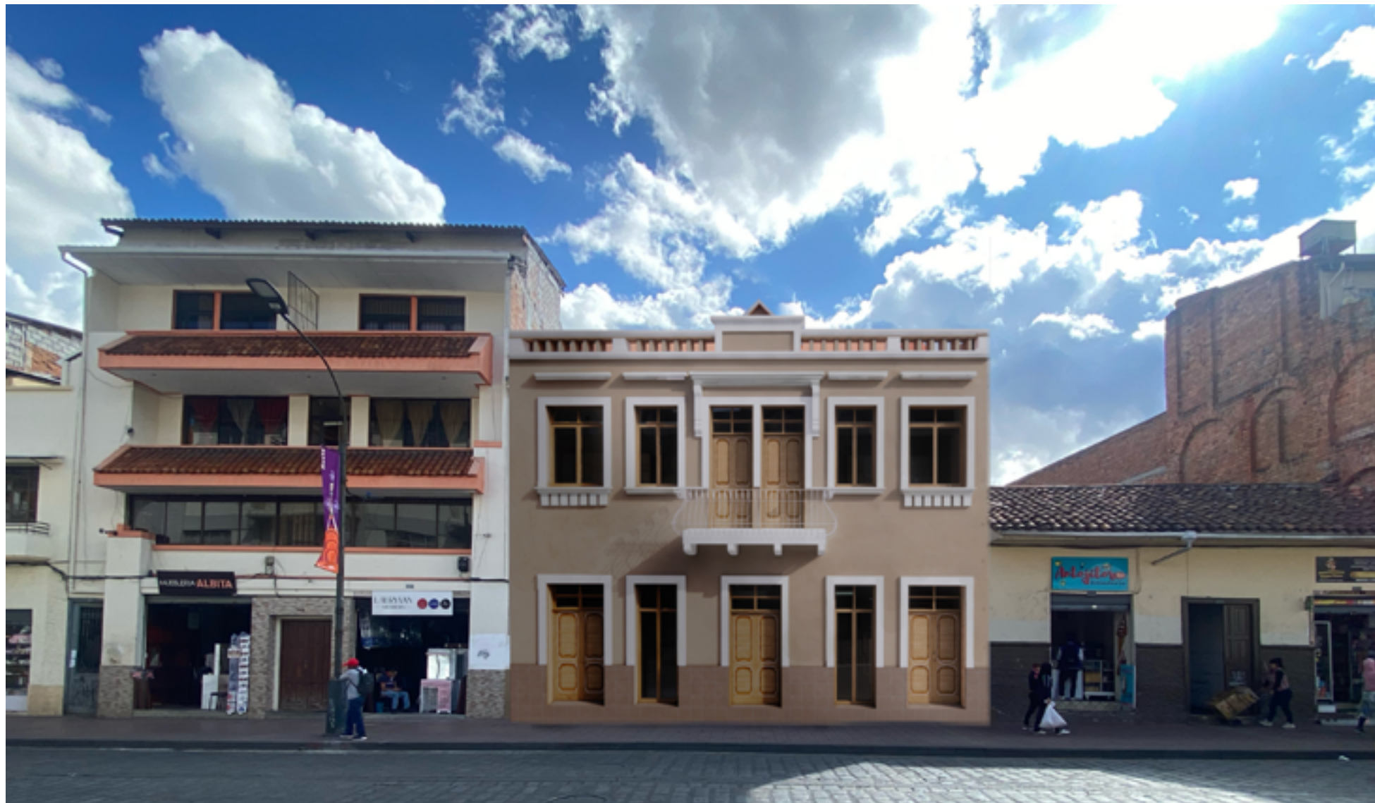
86 Figura 89: Vista desde la Calle Larga hacia el proyecto Fuente: Autoría propia (2025)
