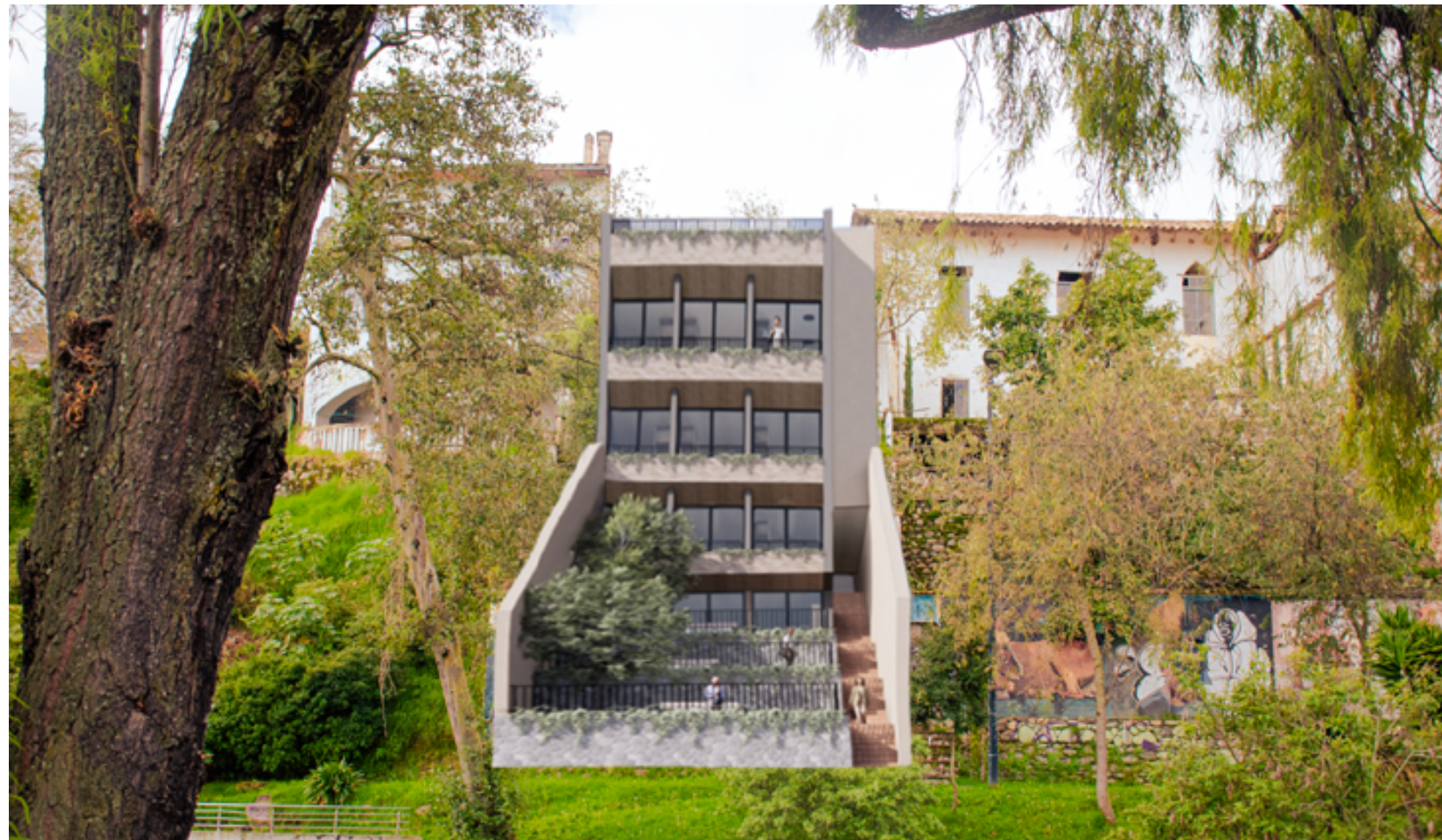
Figura 90: Vista desde la Av. 12 de Abril hacia el proyecto Fuente: Autoría propia (2025)
