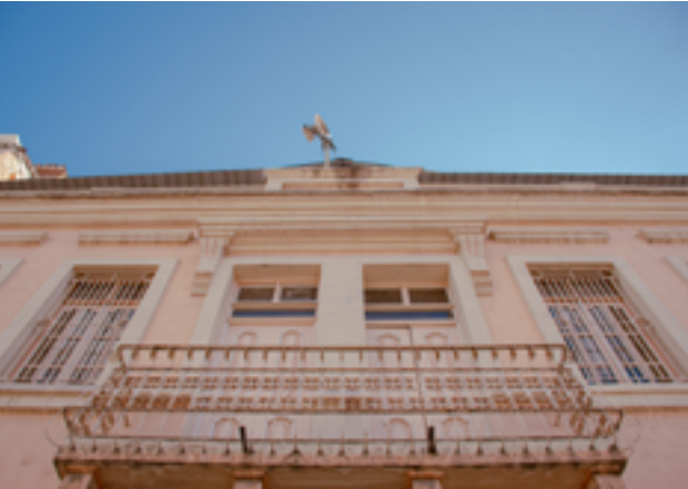
Figura 56: Vista hacia los elementos ornamentales de la fachada principal Fuente: Autoria propia (2025)
