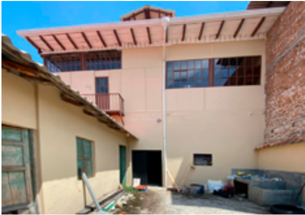
Figura 54: Vista de la fachada posterior desde el patio Fuente: Autoria propia (2025)
