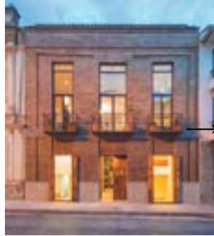
Figura 14: Materialidad bloque antiguo fachada exterior casa Juan Jaramillo. Nota. Intervención realizada por Surreal Estudio. Recuperado de ARQA, 2023.
