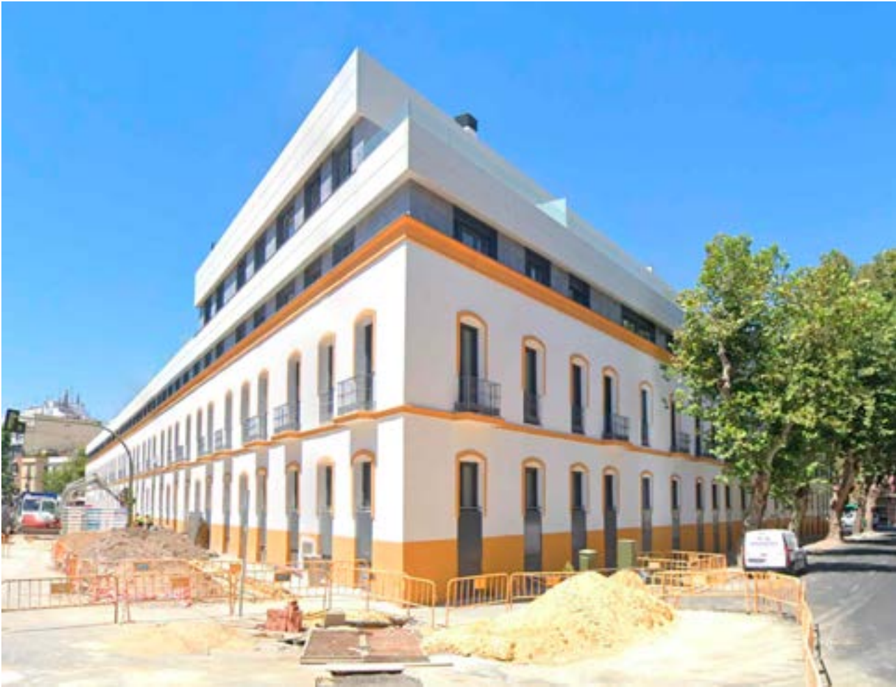
Figura 23: Fachada exterior edificio Aclea La Florida. Nota. Intervención realizada por ÁRQURA Home. Recuperado de Nueva Obra (sf).
