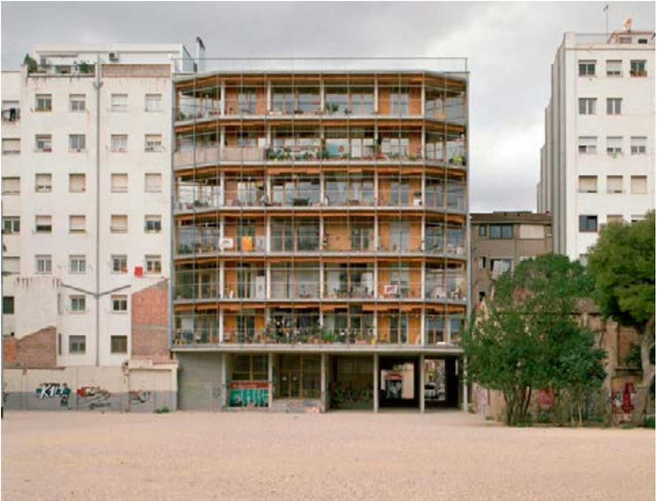
Figura 29: Fachada exterior del edificio La Borda. Nota. Fotografía de Guillaud, F. del proyecto diseñado por Lacol, 2018. Recuperado de ArchDaily, 2019.
