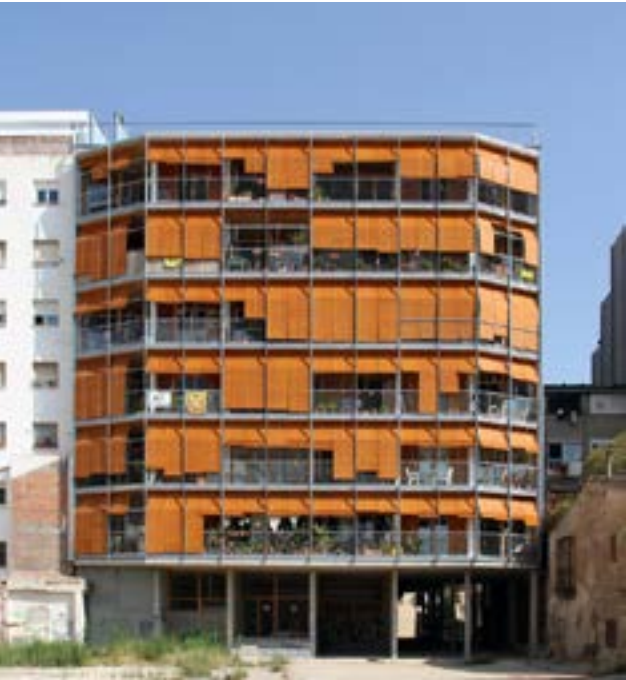
3.3 Edificio La Borda
