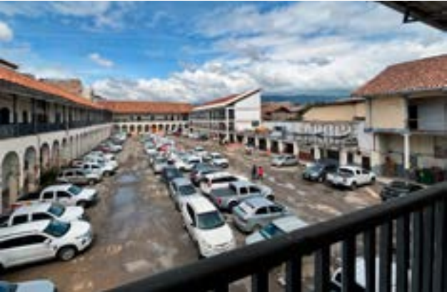
Figura 52: Estado actual del antiguo colegio Febres Cordero. Nota. Fotografía propia.
