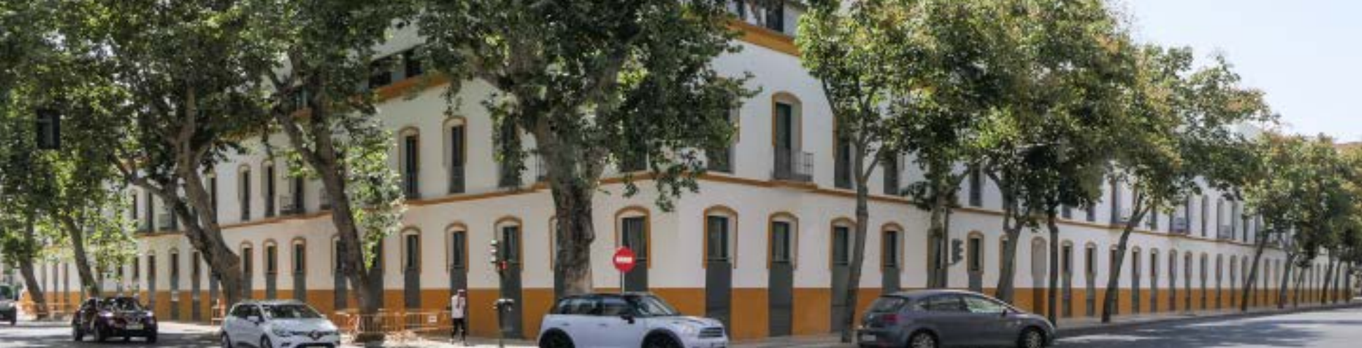
Figura 28: Fachada exterior edificio Aclea La Florida. Nota. Intervención realizada por ÁRQURA Home. Recuperado de Nueva Obra (sf).
