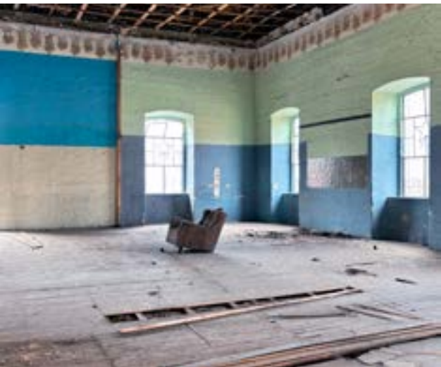
Figura 51: Estado actual del interior del antiguo colegio Febres Cordero. Nota. Fotografía propia.
