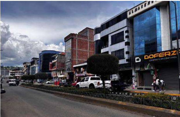
Fig 30. Av. Alberto Ochoa. Fuente: Elaboración Propia.
