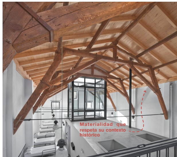
IMG 36. Interior de Albergue. Fuente: (ArchDaily, 2017)
