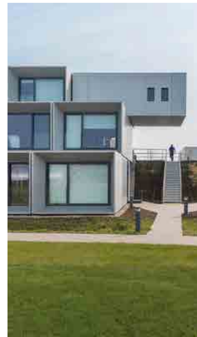
Fig 38: Exterior de los bloques habitacionales y voladizo por Peter L.
