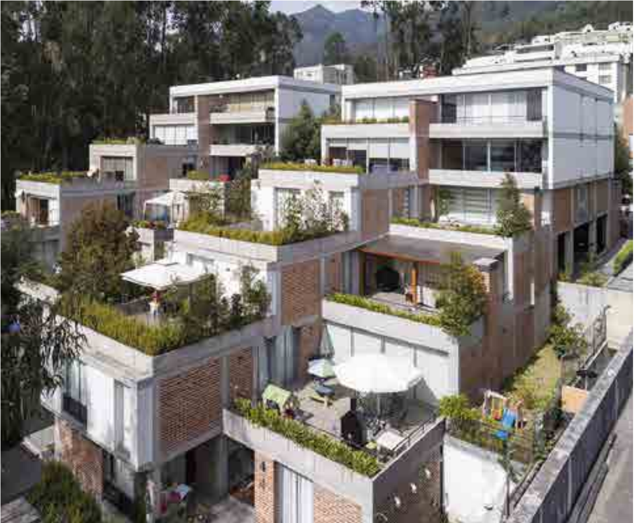
Fig 22: Fotografía aérea de la parte superior del edificio por CCI Arq
