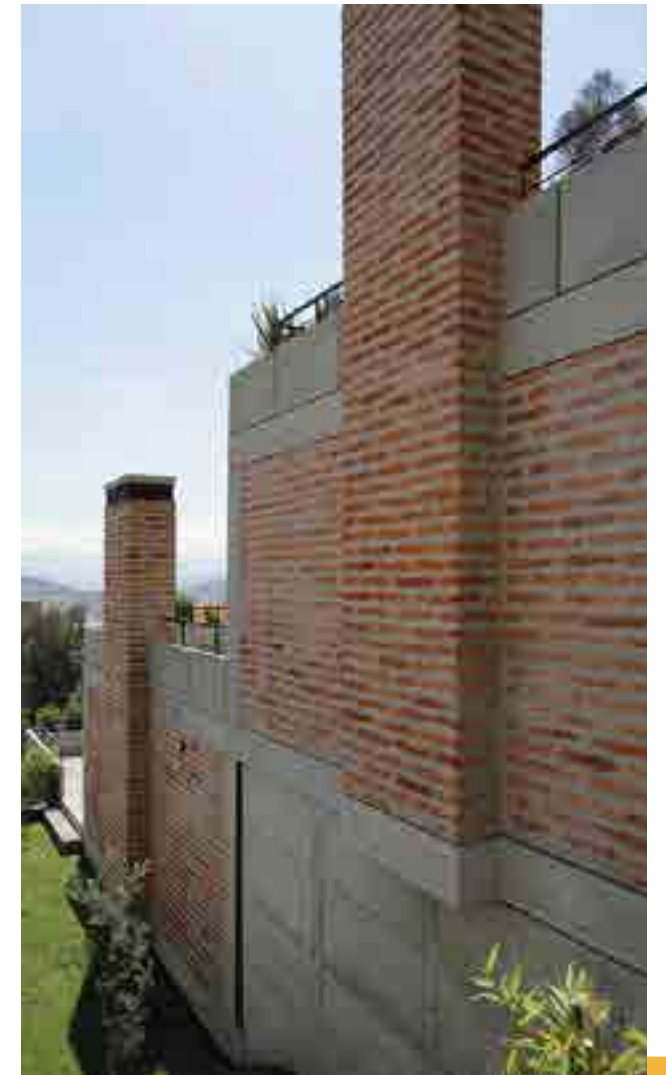
Fig 29: Muros y pilares de concreto y ladrillo del edificio por CCI Arq.
