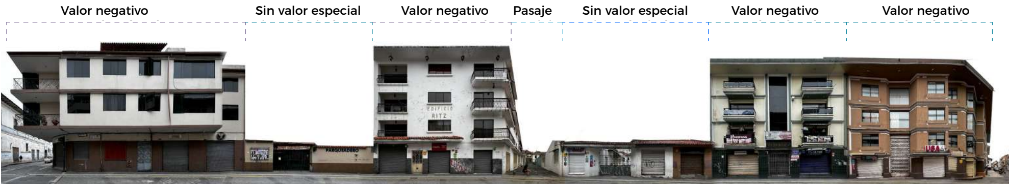
V1.Fachadas calle Gran Colombia
