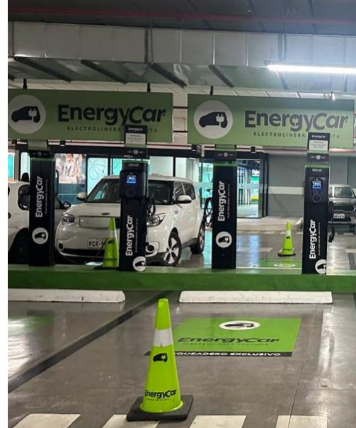
Figura 20: Estación Centro Comercial Wayra Plaza
