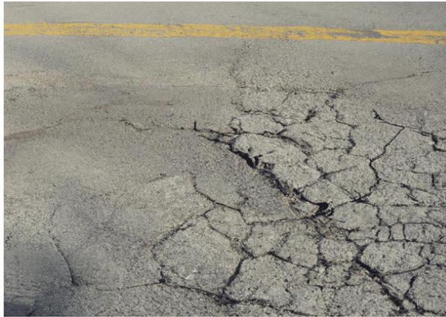
Nota. La figura representa una falla tipo concreto agrietado que el programa es capaz de identificar. Fuente: Las fallas de los pavimentos flexibles son un problema común que puede ocurrir en carreteras y calles, Farro, A, 2023.
