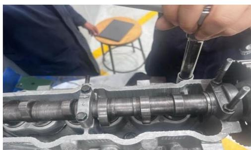
Figura 14 Instalación de árbol de levas
