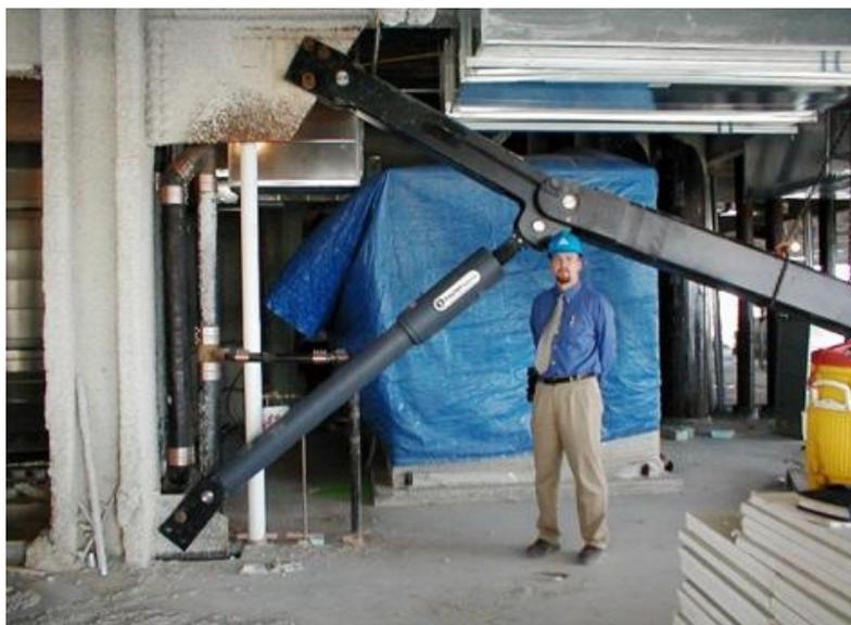
**Figura 1.21** Conexión del sistema de amortiguamiento
