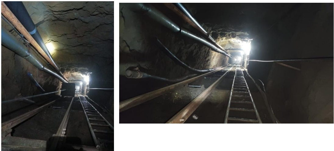
Figura 6 Fotografías del pozo principal de exploración.
