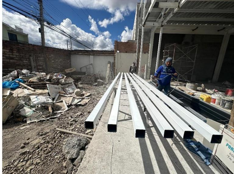
*Nota: Fotografía tomada del proceso de colocación de anticorrosivo en perfiles*
