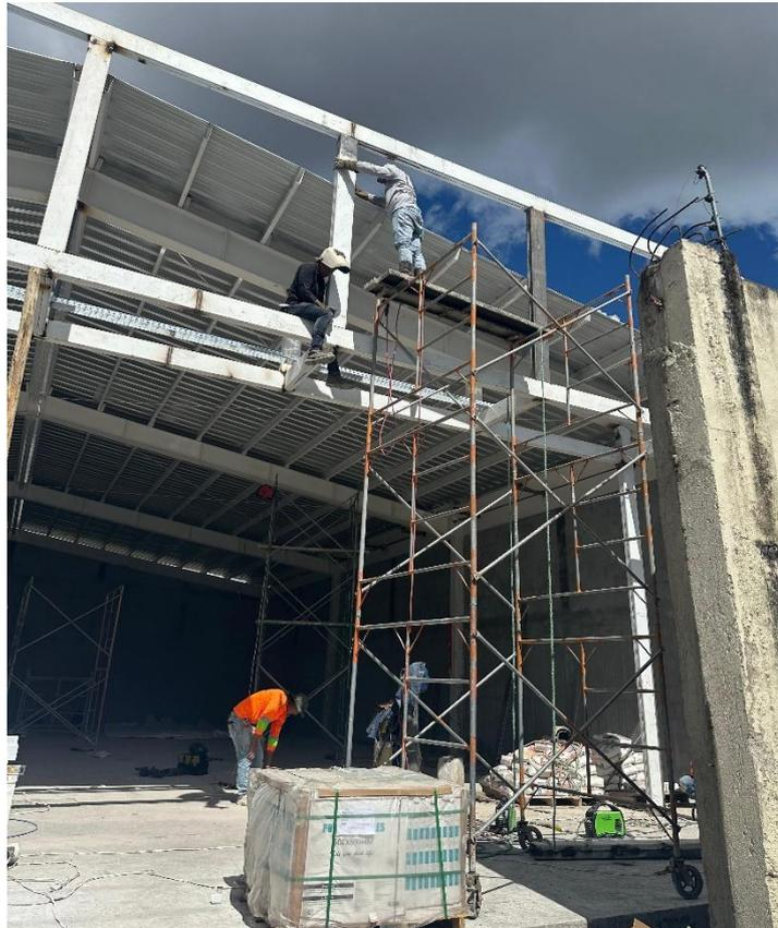
*Nota: Fotografía correspondiente al proceso de soldadura de los perfiles estructurales*
