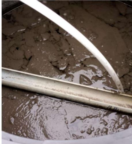
**Figura 13** | Bulking generado en sedimentador
