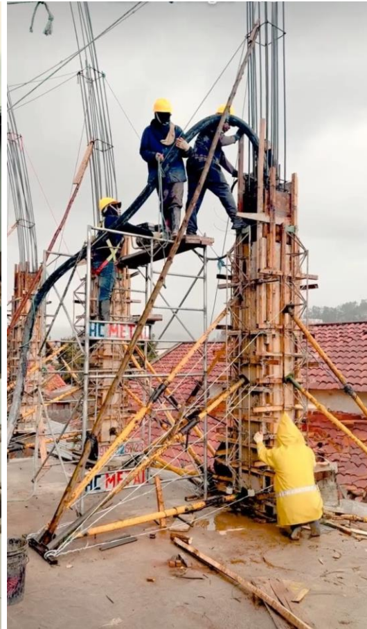
Figura 1b. RiesgoCrítico2: Caídas en altura Complejo Médico Roma. 08/03/2025.
