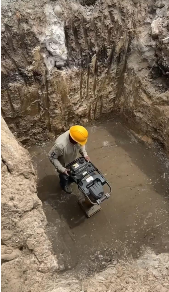
Figura 3a. RiesgoCrítico3: Golpes por maquinaria pesada. Complejo Médico Roma. 19/10/2024.
