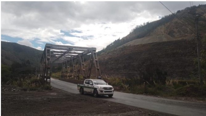
Figura 23: Entrada Agregados El Austro. Sector: El Descanso
