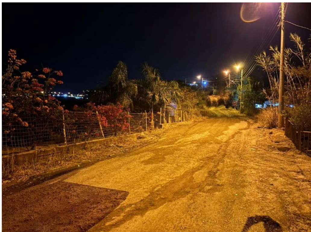
Figura 20. Humedad en la vía, producto de fugas de la red principal de agua en la zona de Los Pueres.
