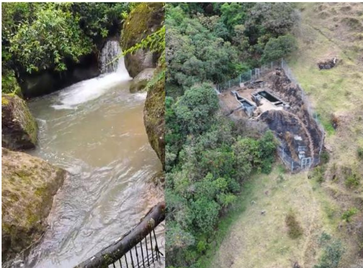
Figura 1. Captación de agua cruda Paccha.
