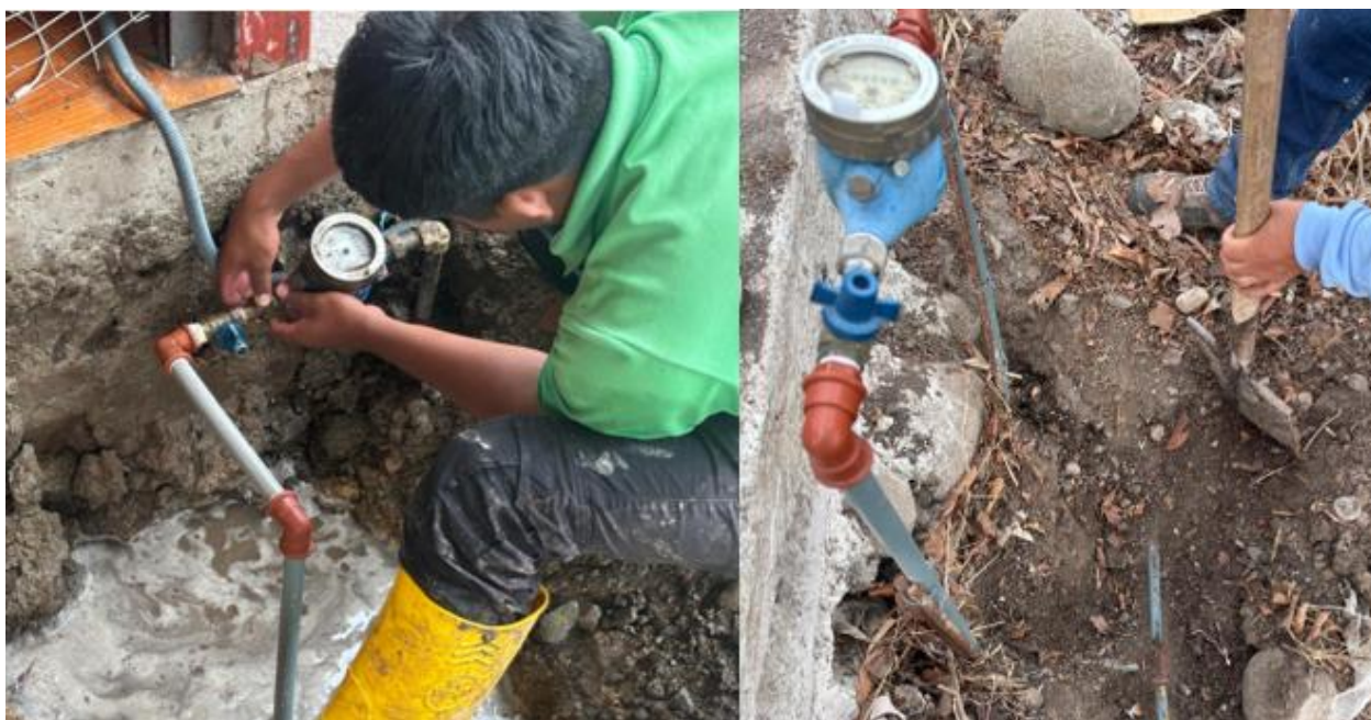
Figura 22. Inspección de acometidas domiciliarias
