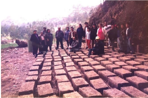
Figura 60 Adobes para la reconstrucción de la casa
