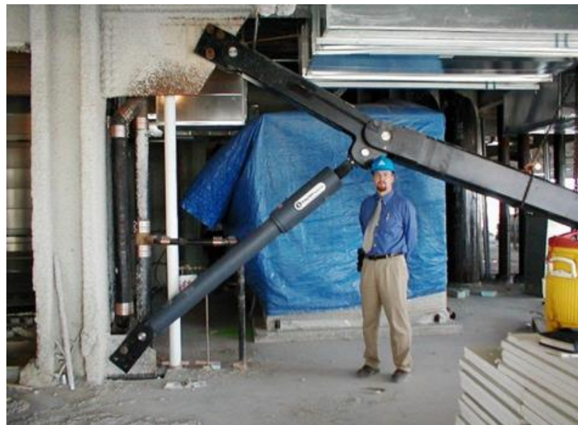
Figura 1. 23 Conexión del sistema de amortiguamiento
