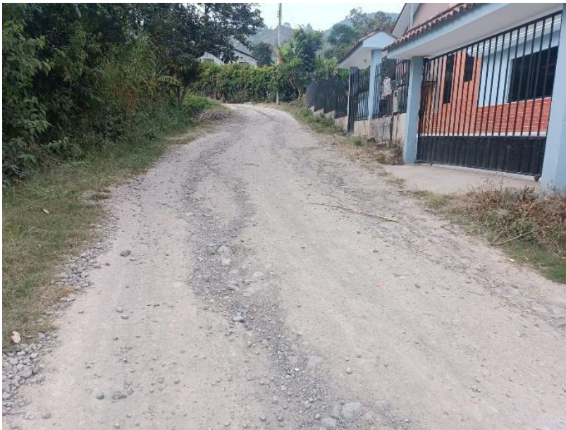
Figura 14 Carretera de lastre, comunidad Naranjito
