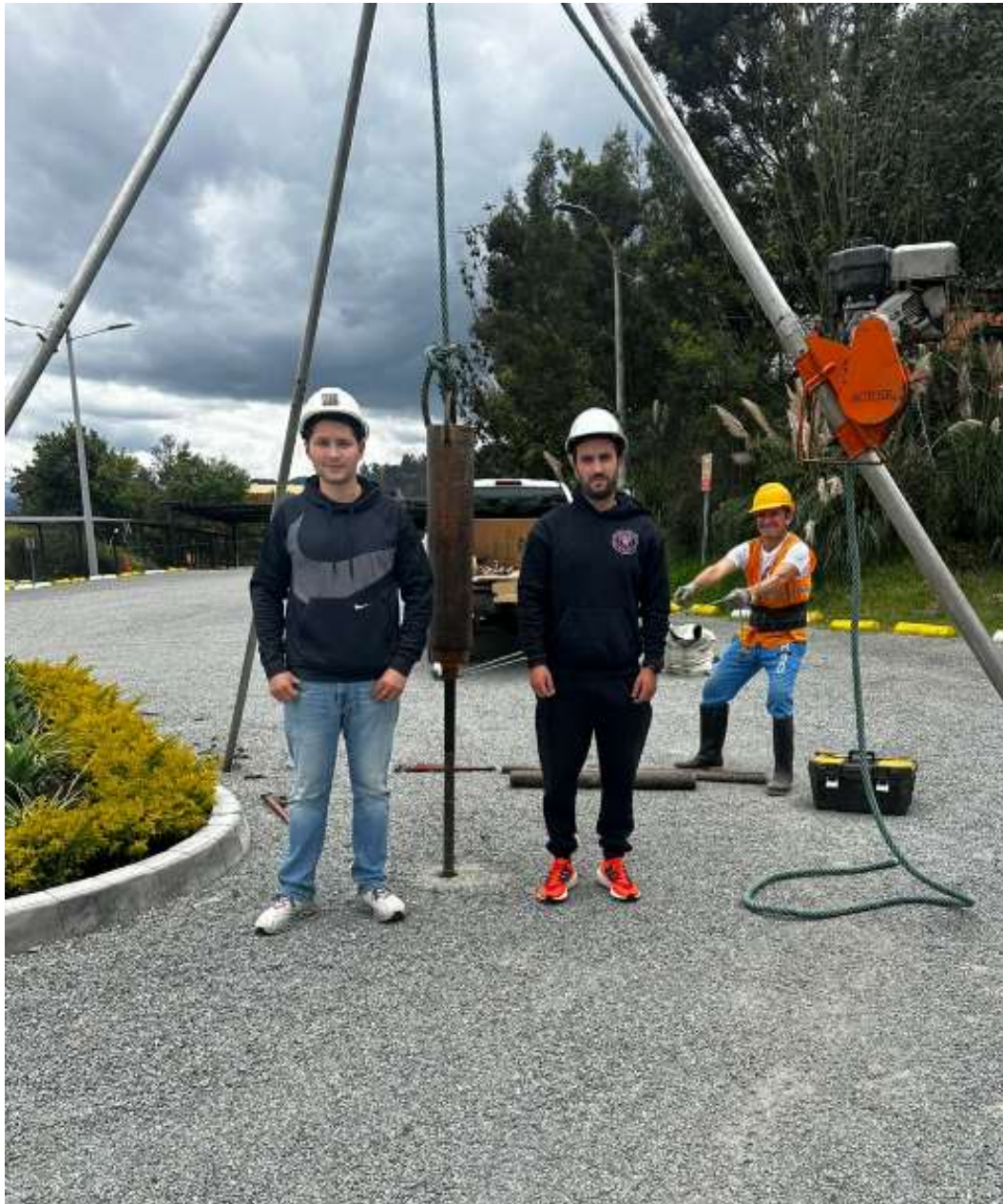
Figura 2-10: Ensayo SPT, punto 7.
