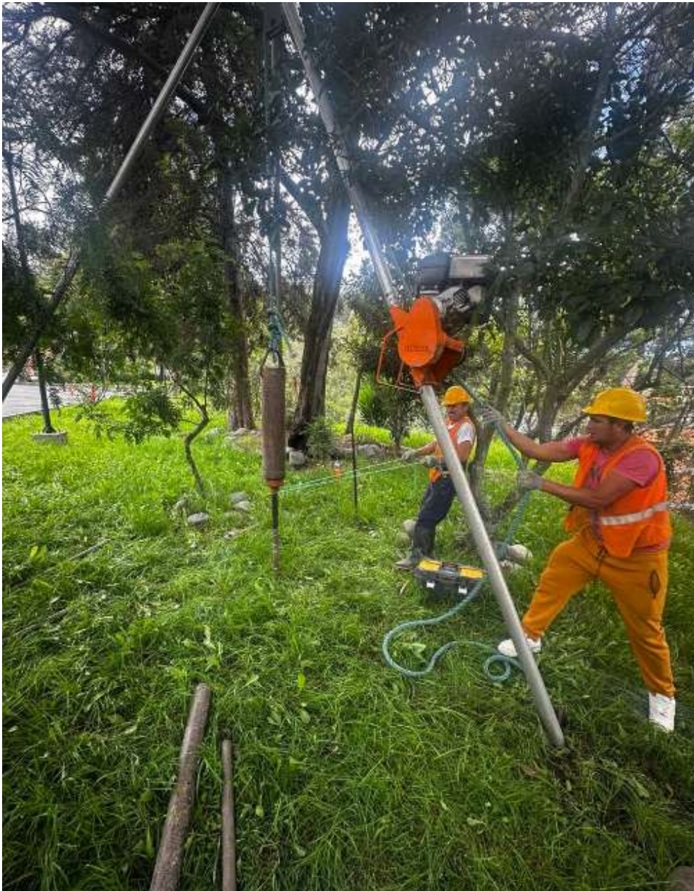
Figura 2-7: Ensayo SPT, punto 4.
