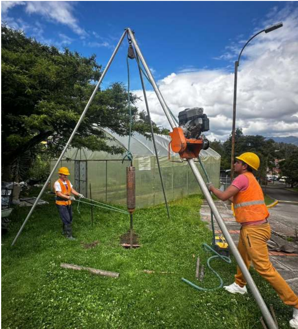
Figura 2-5: Ensayo SPT, punto 2.
