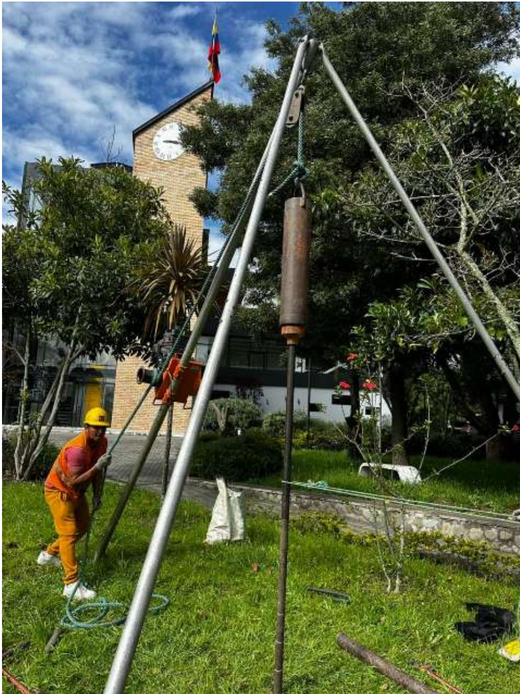
Figura 2-8: Ensayo SPT, punto 5.
