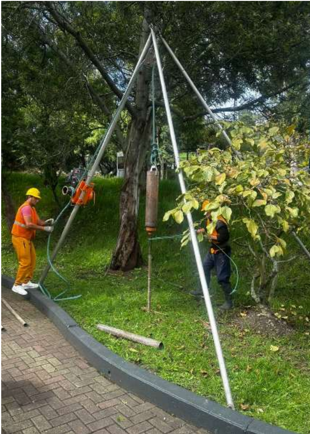
Figura 2-11: Ensayo SPT, punto 8.
