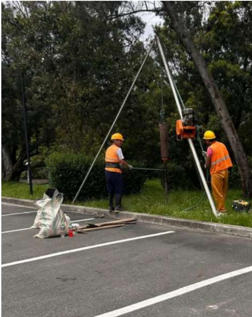
Figura 2-6: Ensayo SPT, punto 3.
