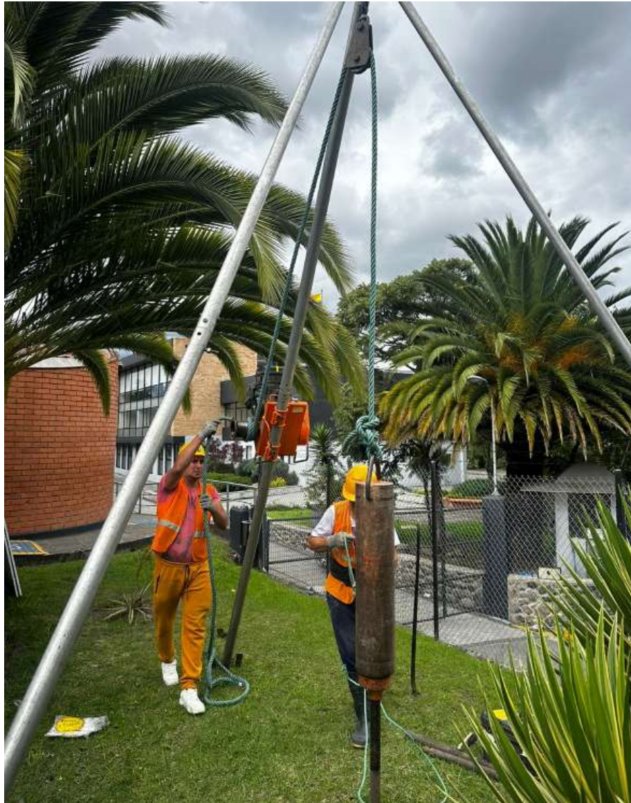
Figura 2-4: Ensayo SPT, punto 1.
