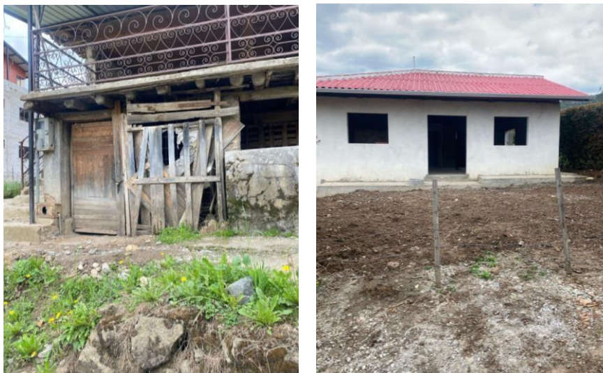
Figura 2.9 Casas inhabitadas que cuentan con medidor
