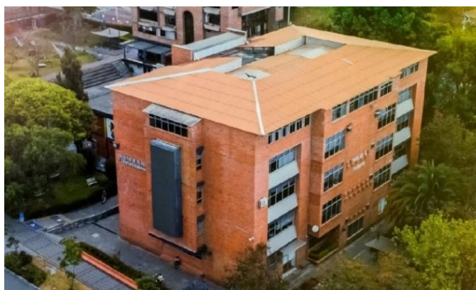
Figura 1.1 Fotografía de la fachada principal del Edificio B1
