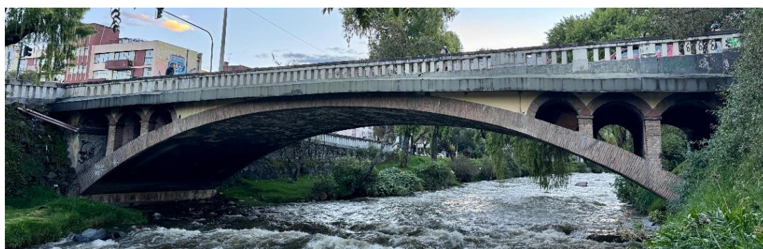
Figura 1.1: Vista general del Puente del Centenario.
