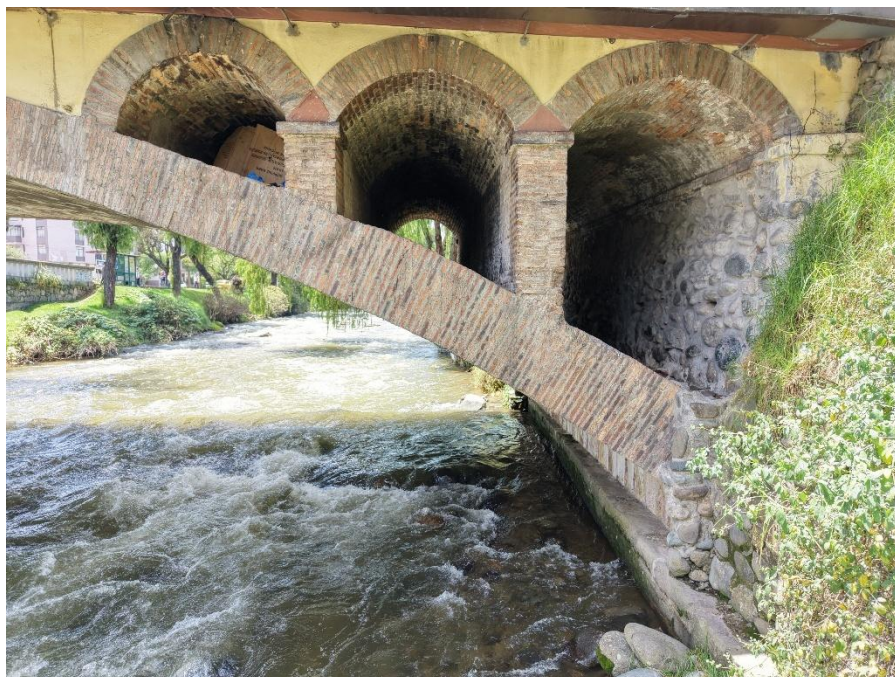
Figura 5.2: Detalle de apoyos y estribos del Puente del Centenario, representativos de las condiciones de borde.
