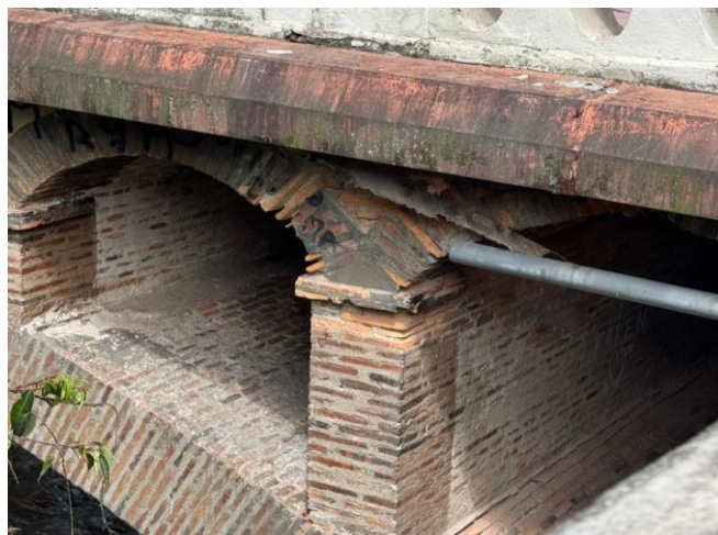
Figura 3.1: Detalle de la mampostería del Puente del Centenario.
