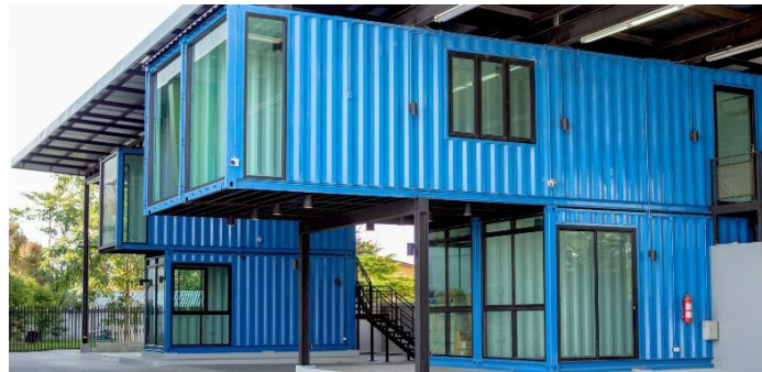
Figura 1-7: Construcción con Contenedores Marítimos
