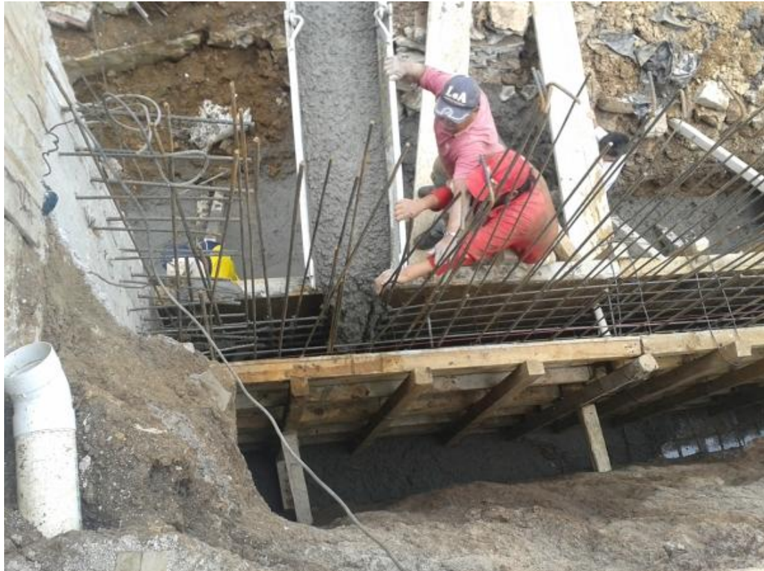
Figura 2-2: Encofrado y colado tradicional.
