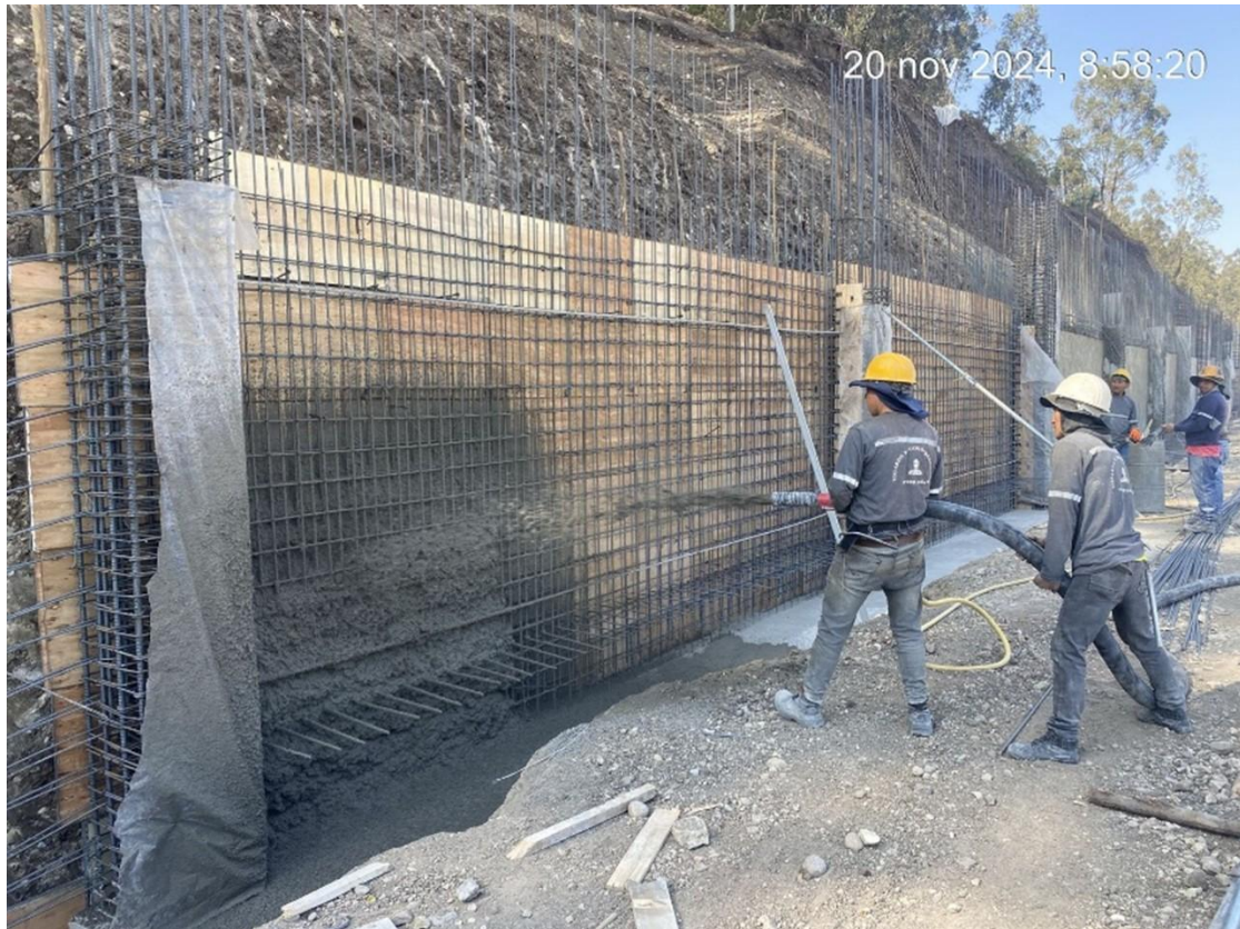
Figura 3-3: Método de proyección neumática (Shotcrete).
