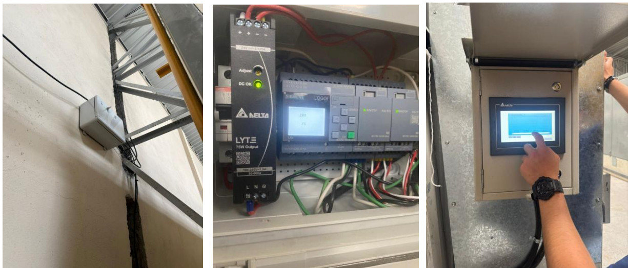
Figura 16. Implementación de PLC a Pantalla
