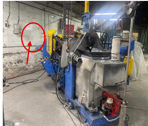
Figura 16: Lugar donde se colocó el tablero cerca de la inyectora
