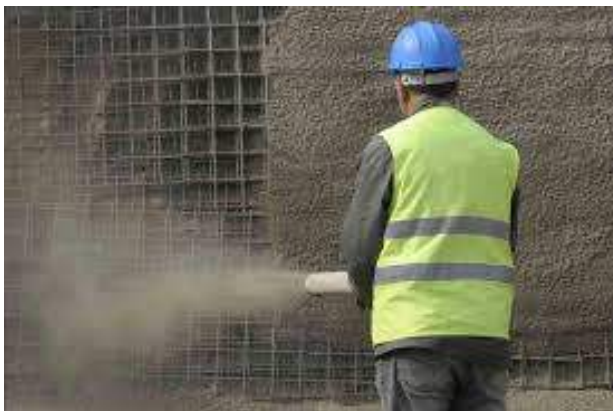
Shotcrete vía húmeda
