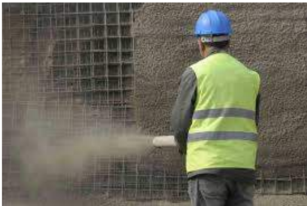
Shotcrete vía húmeda
