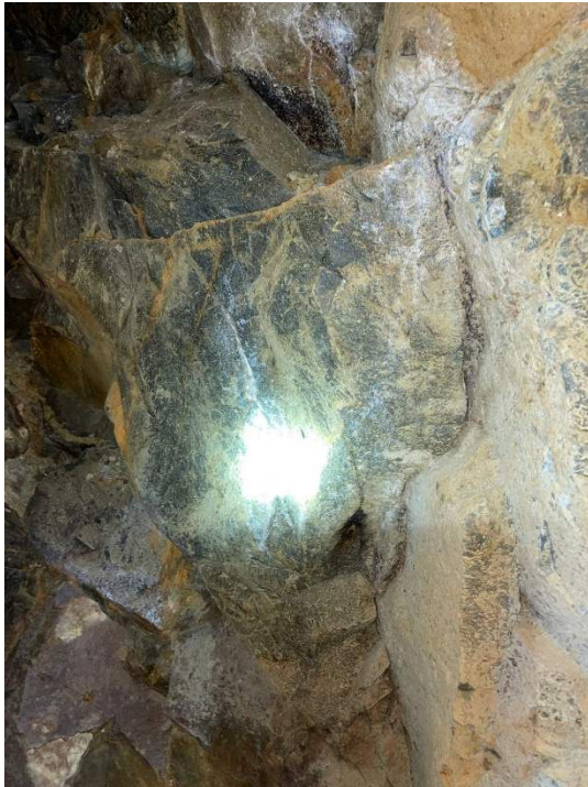
Estado de alteración
