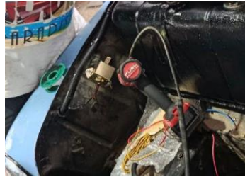
Figura 30: Bomba de gasolina eléctrica instalada.
