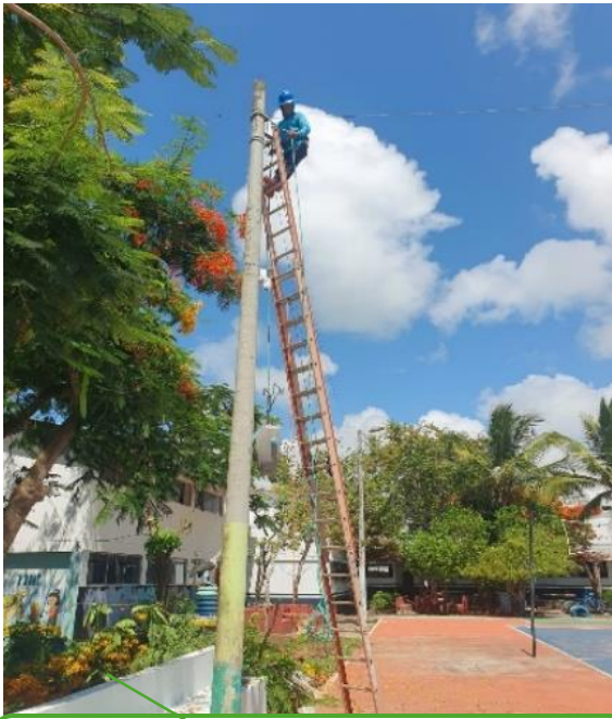
Corte de Árbol para llevar el cable del inversor a la lampara
