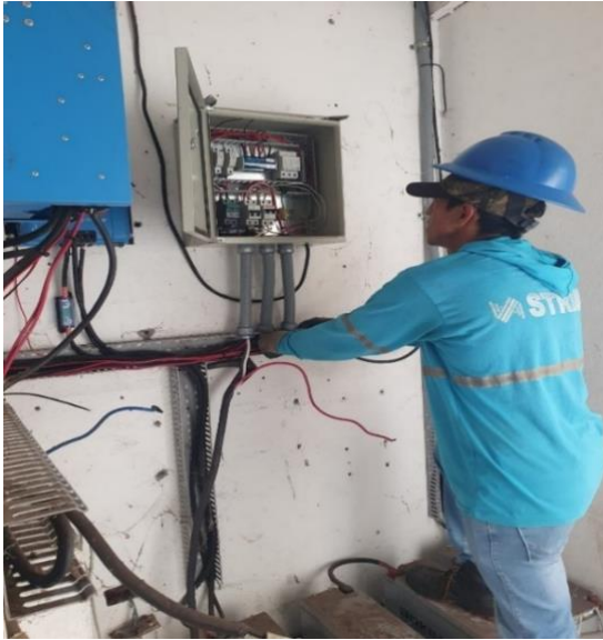
Figura 4. Aislamiento de conductores con pérdida de recubrimiento en mal estado
