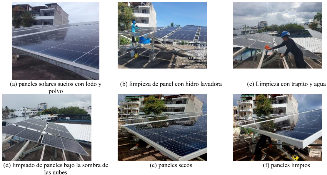
Figura 13. Proceso de limpieza de paneles fotovoltaicos de suciedad, lavado, secado y resultado final
