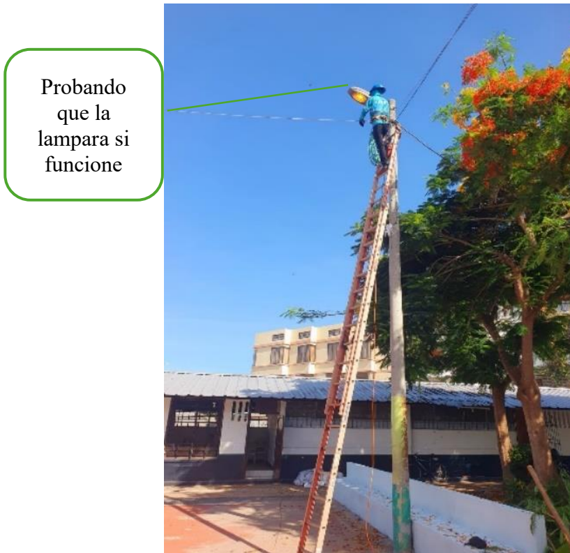
Figura 7. Instalación de la fotocélula y ajuste de la orientación de la luminaria.
