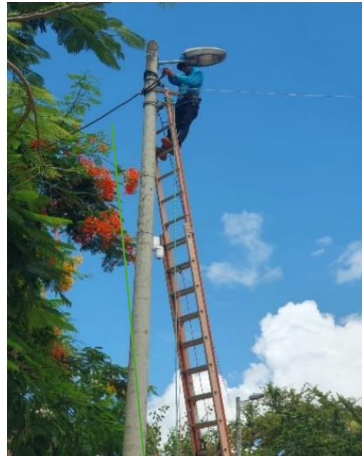
Templando el cable 3x10 Concéntrico
