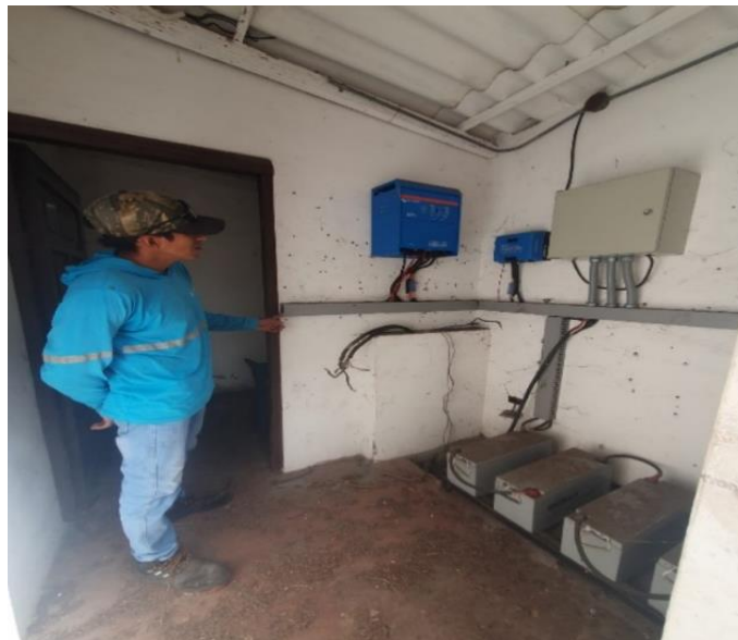
Figura 2. Inspección de los inversores
