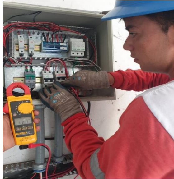
Figura 4. Aislamiento de conductores con pérdida de recubrimiento en mal estado
